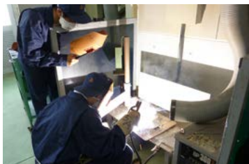
アーク溶接実習
