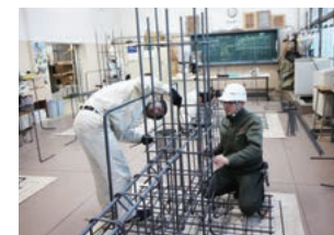
3級鉄筋組立技能検定(1・2年生)
